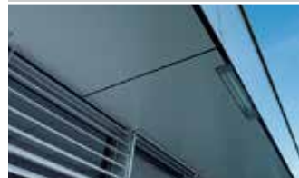
Balcony claddings | Habillage de balcons | Balkonverkleidungen
